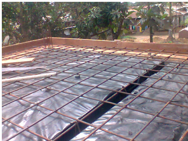
Latrine roof slab prior to concrete pour
